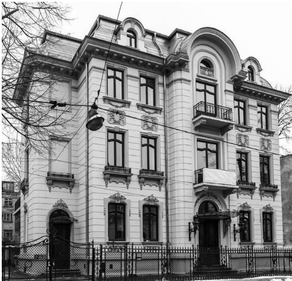
una dintre casele reabilite din zona construită protejată Caimatei
