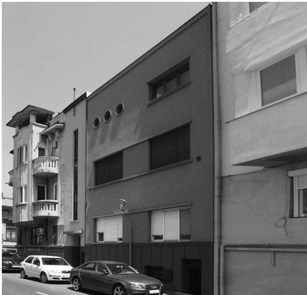
Unul dintre imobilele reabilitate de pe strada Mântuleasa
