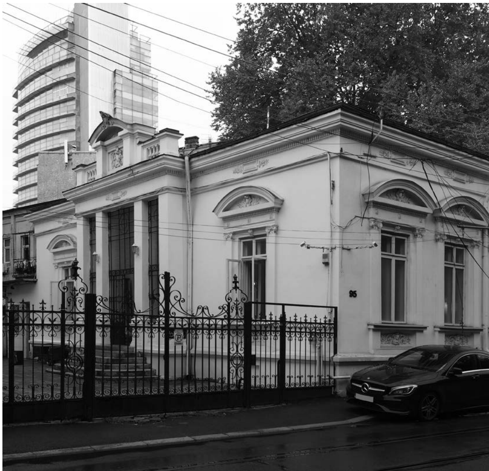
Una dintre casele reabilite de pe Calea Moșilor.
